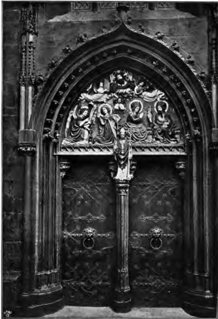
Fig. 183. Kiedrich. Pfarrkirche. Westportal.
